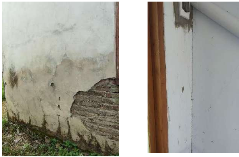
Gambar 1. 2 Keretakan Dinding
